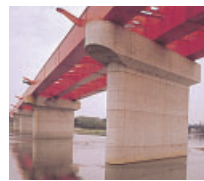
グラウト用無収縮材が使用された橋梁
