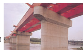
グラウト用無収縮材が使用された橋梁
