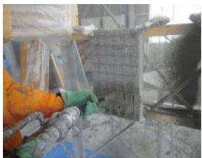
吹きつけ状況1
