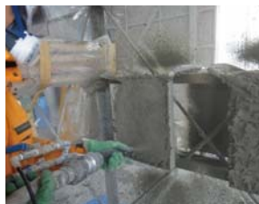
吹きつけ状況2
