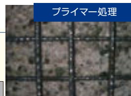
プライマー処理
