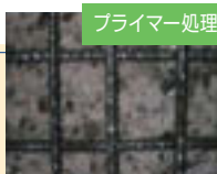
プライマー処理
