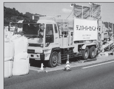
床版上面増厚施工
