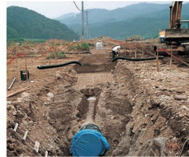
▲ 圃場整備小排水路管路化工事
