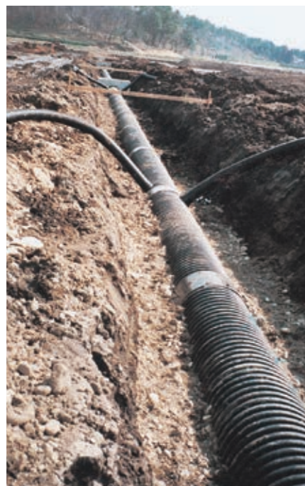
▲小排水路管路化工事
