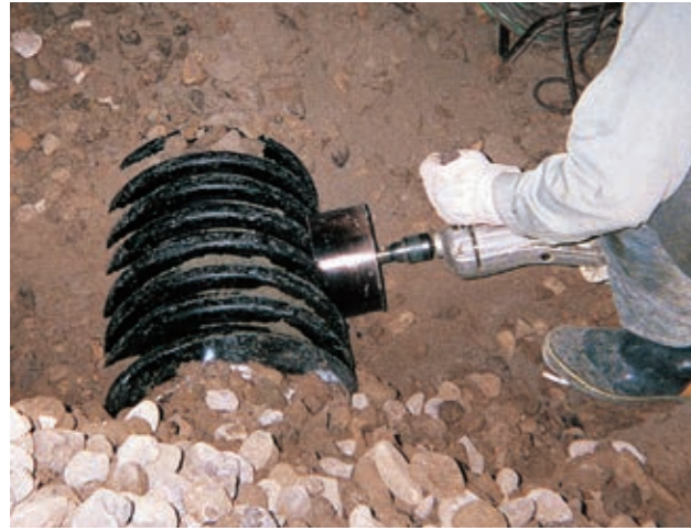
▲ トンネルセンタードレン ゴム支管用穴開け作業
