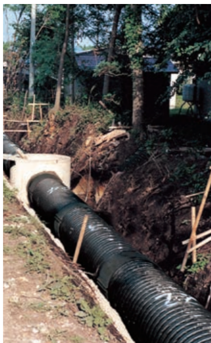
▲道路排水工事
