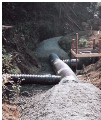
▲土捨場防災暗渠工事
