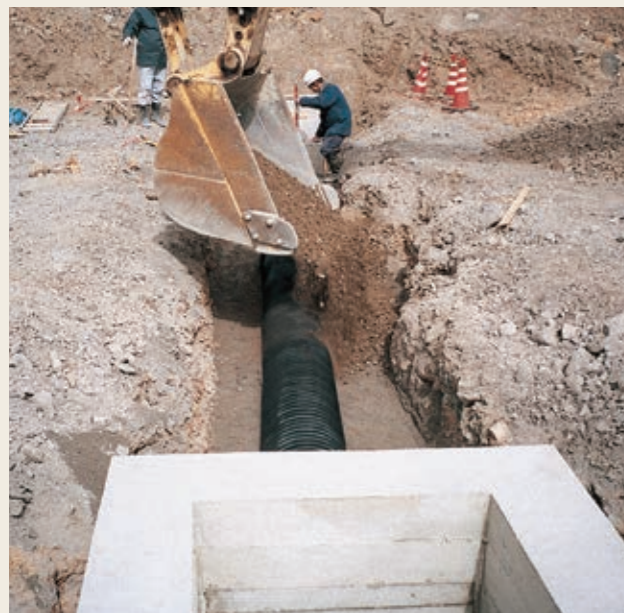
▲ NEXCO用排水管工事
