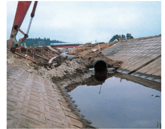
▲ 河川改修仮排水工事
