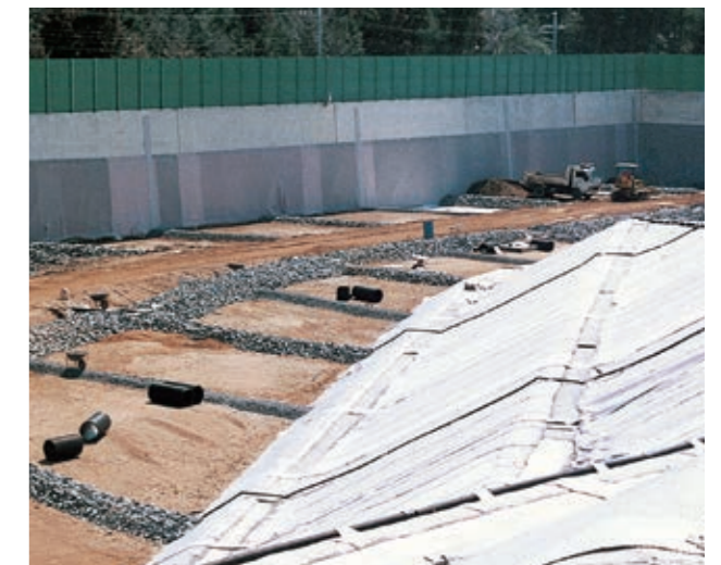
▲ 一般廃棄物処理場浸出集排水・ガス抜き管工事
