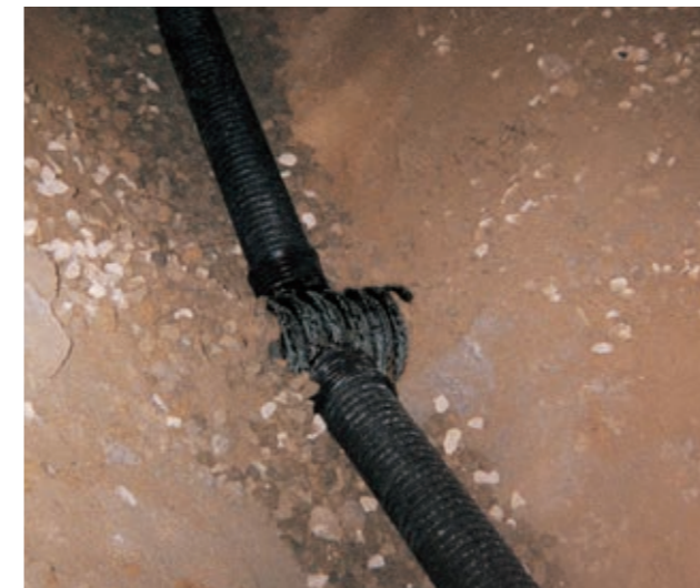
▲ トンネルセンタードレン横断管接続
