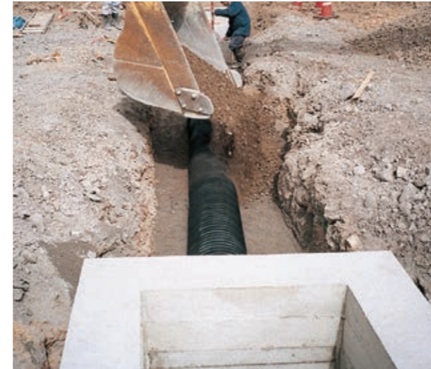
▲ NEXCO用排水管工事
