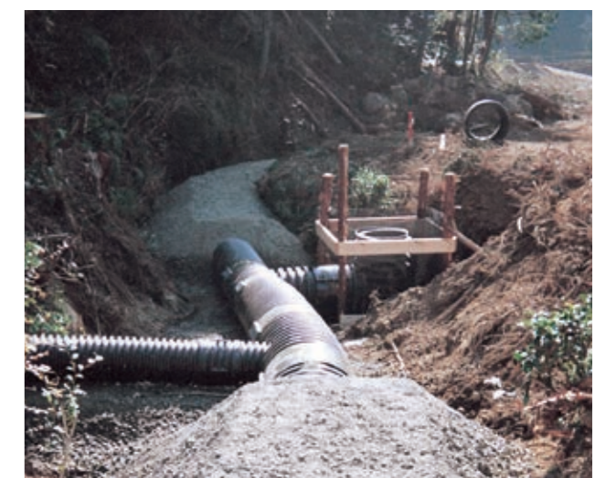
▲ 土捨場防災暗渠工事
