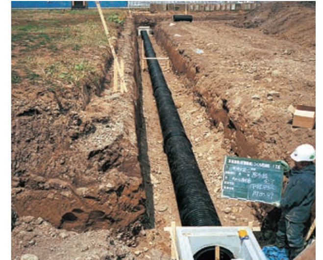
▲ 小排水路の管路化工事
