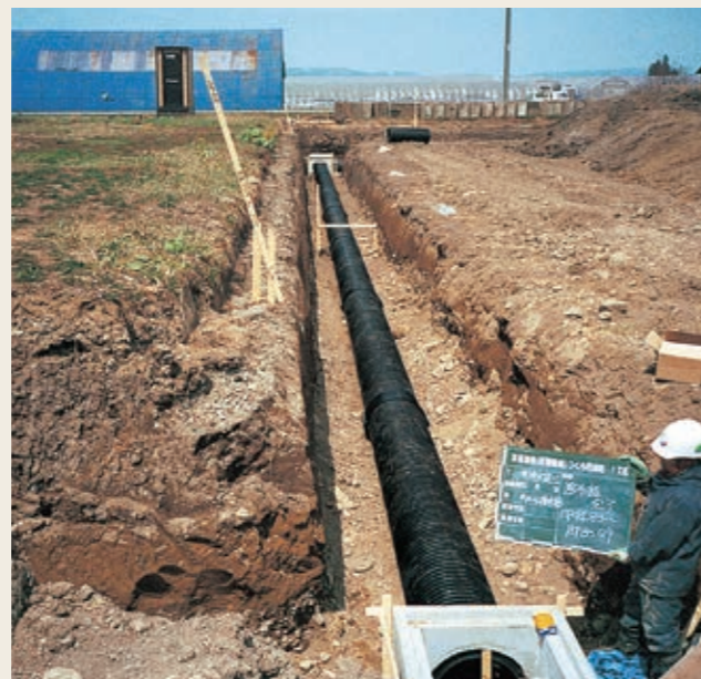
▲ 小排水路の管路化工事
