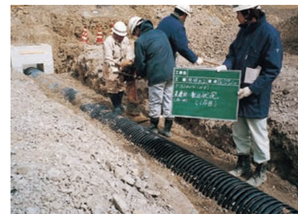
▲NEXCO用排水工工事
