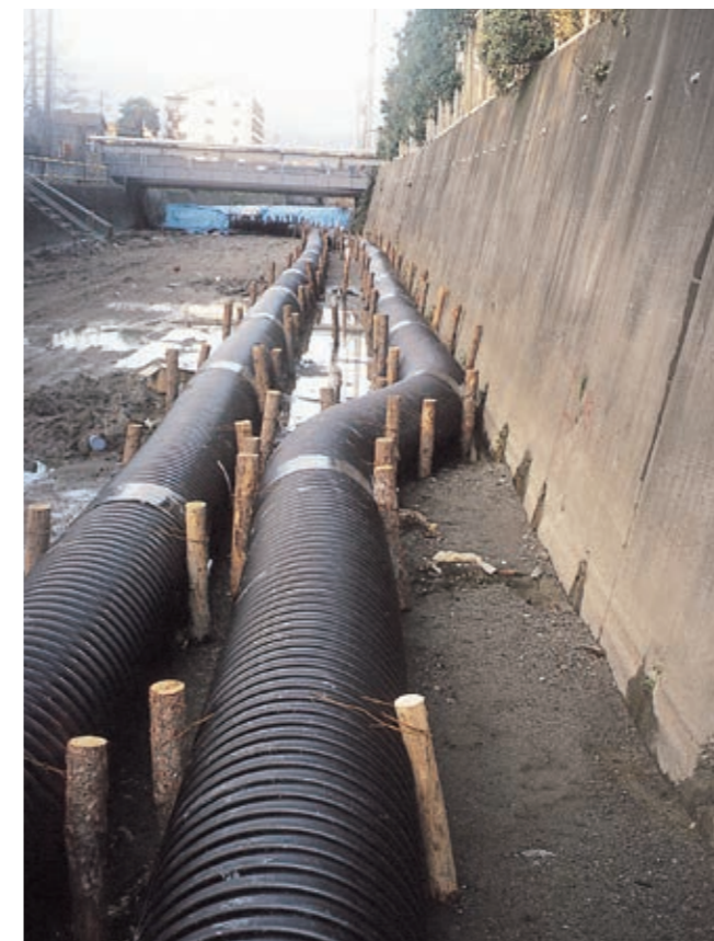
▲河川改修(水路切り回し)工事
