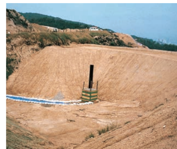
▲ 土地造成堅形集排水管工事
