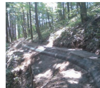
▲中山間農業用水路改修工事 (イメージ)
