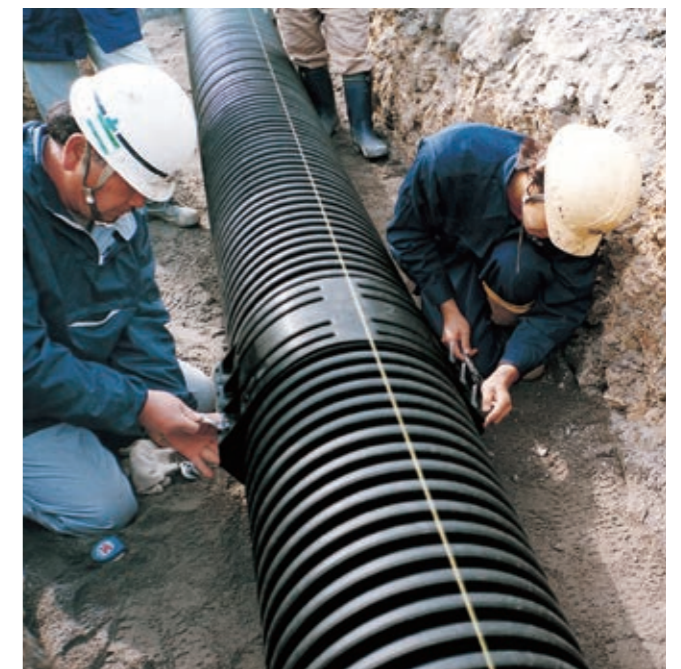
▲リング管ソケットの取付け
