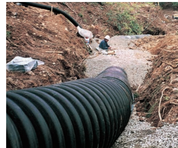
▲ 土地造成防災暗渠排水工事
