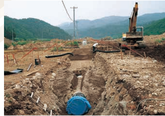
圃場整備小排水路管路化工事
