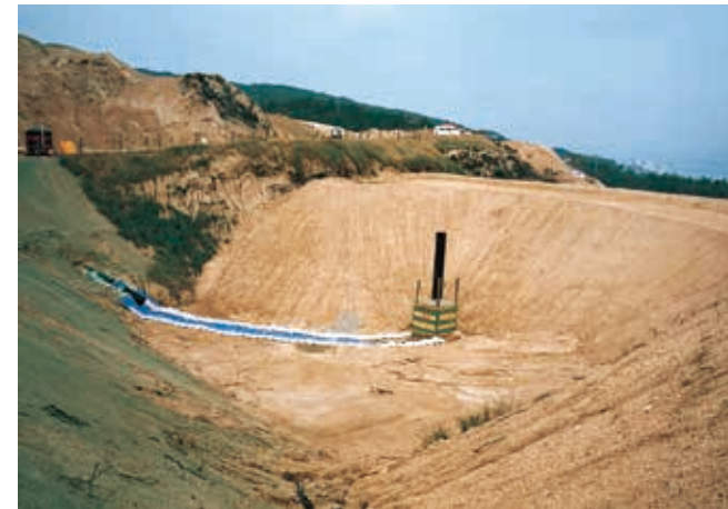
土地造成堅形集排水管工事
