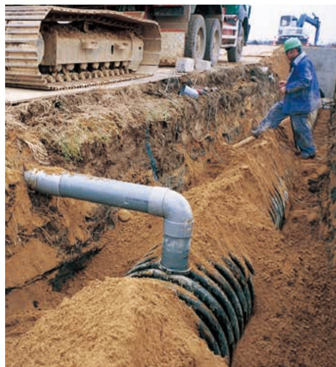
小排水路の管路化工事、枝管にVU管使用
