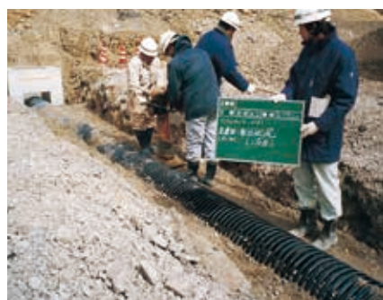
NEXCO用排水工工事
