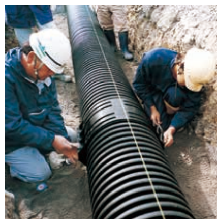
リング管ソケットの取付け
