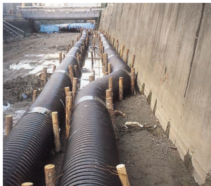
河川改修(水路切り直し)工事
