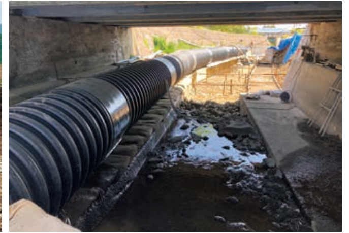
河川改修排水工事
