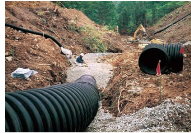
土地造成防災暗渠排水工事
