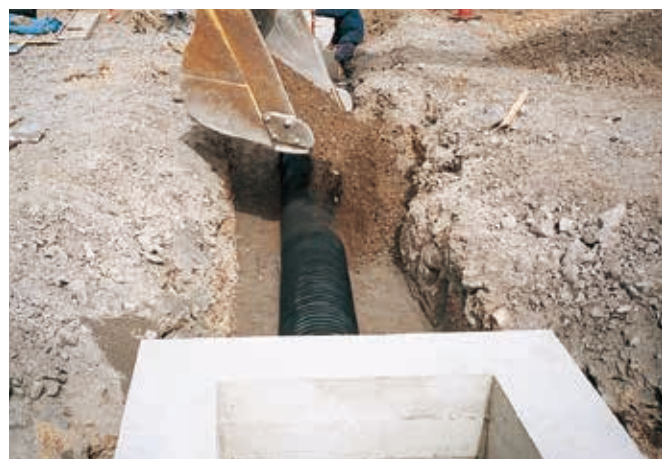
NEXCO用排水管工事
