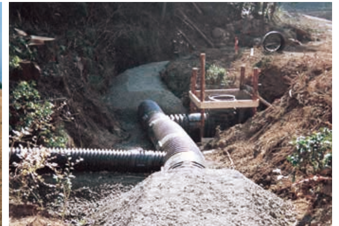
土捨場防災暗渠工事
