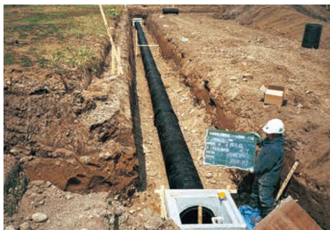
小排水路の管路化工事
