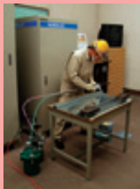
アプリケーターによる塗布
