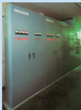
配電盤の組立て
