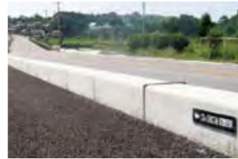
CO 2 -SUICOM施工実績(島根県浜田市)
