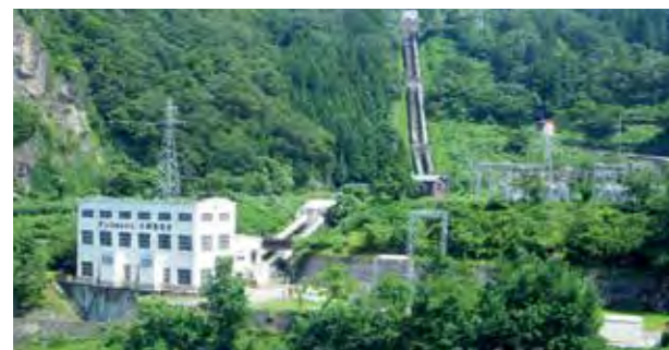
当社各水力発電所の集中管理を行う大網発電所
