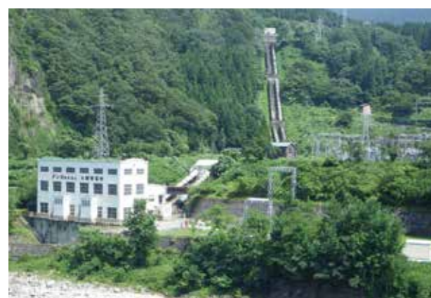
当社各水力発電所の集中管理を行う大網発電所
