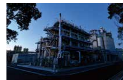
写真4 千葉工場 超高純度アセチレンブラック製造設備を竣工
