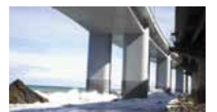
北陸自動車道 親不知海岸高架橋/電気化学的脱塩工法
