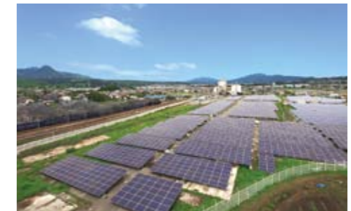
DENKAソーラーパワーしづかわの全景
