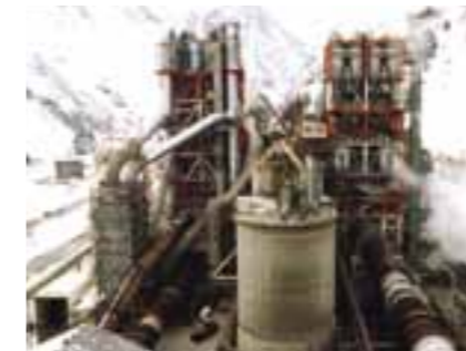
青海工場セメントプラント
