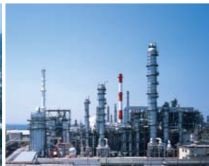
千葉工場 スチレンモノマー製造設備(CM-4)
