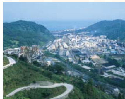
青海工場全景
