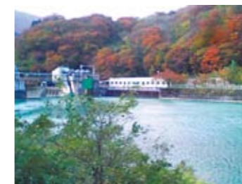
水力発電所の堰堤
