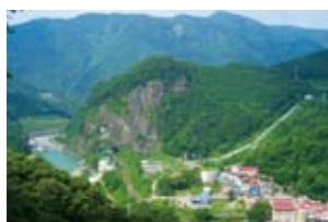
大網発電所(水力)
