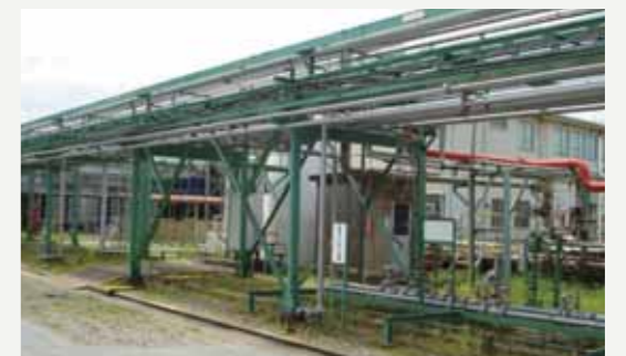
千葉工場パイプラック補強
