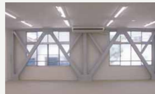
大船工場厚生棟補強
