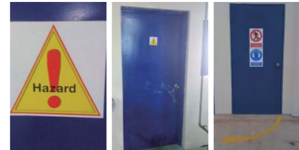
Hazard Mark Hazard Markの添付例 対策例 (扉の前の床面に注意を促すマークを表示)
