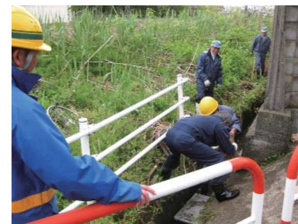
せきぎら 用水路の堰浚い
