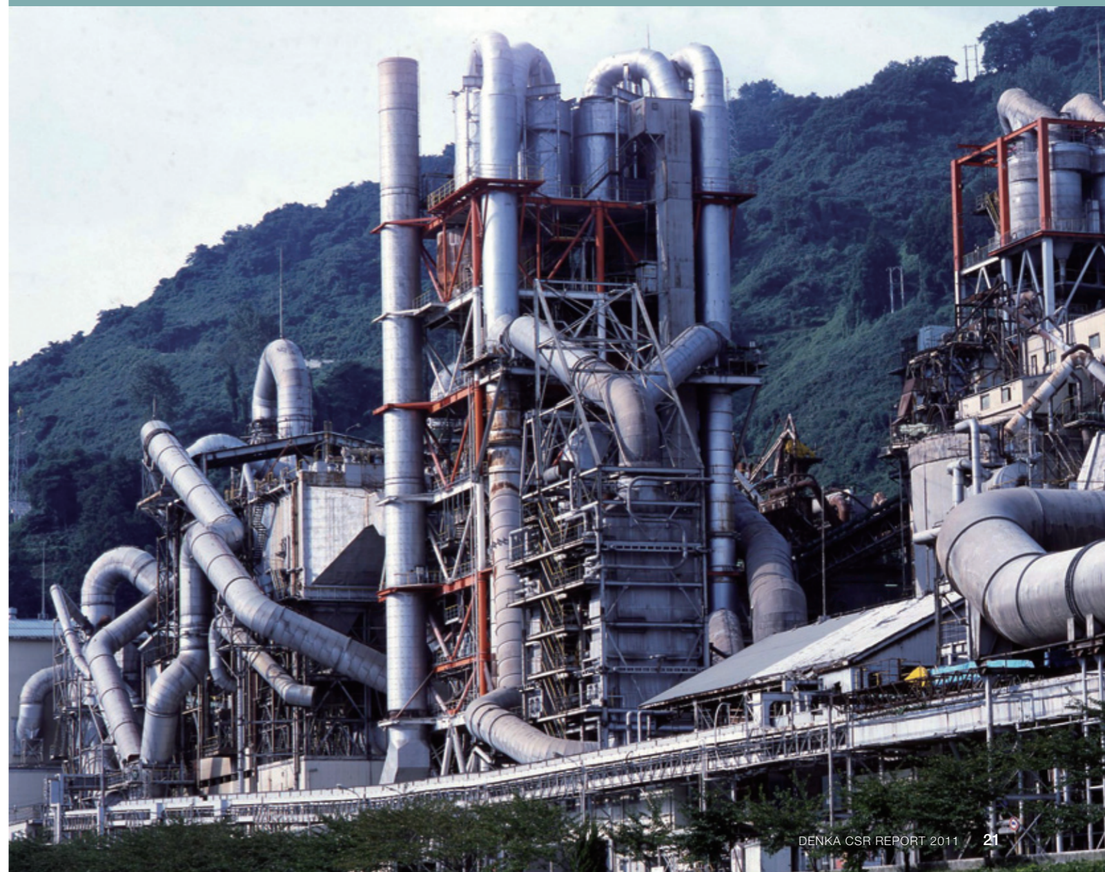
青海工場のセメントプラント
