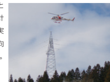
ヘリコプターによる送電線の点検
