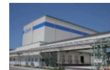
自動定温倉庫と製造ラインからの自動搬送装置
