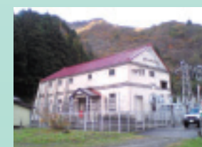
小滝川発電所
