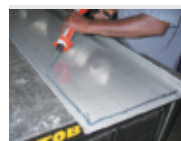
接着剤塗布作業
