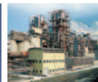
廃棄物受入などでリサイクルにも活躍するセメント工場
