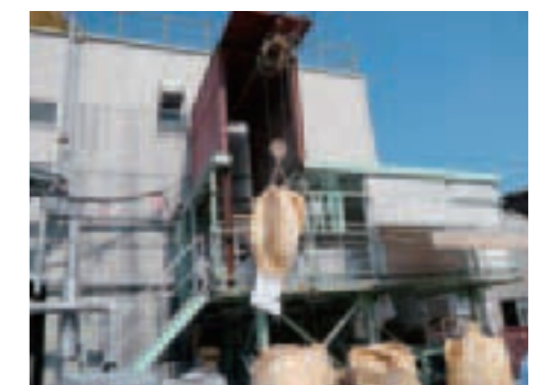
ばいじん・ダスト類リサイクル処理施設 (大牟田工場)
