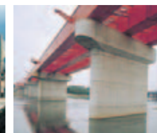
グラウト用無収縮材が使用された橋梁
