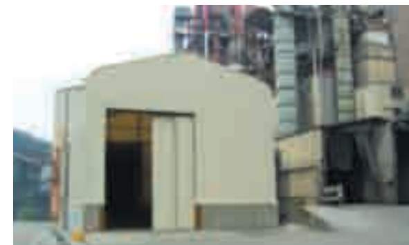
下水汚泥受入倉庫
