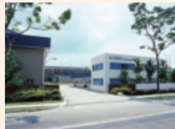
デンカアドバンテック トラス工場 (シンガポール)
