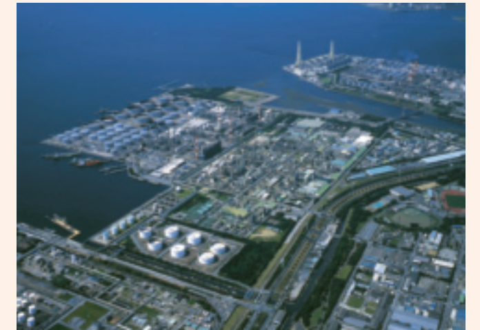
千葉工場全景
