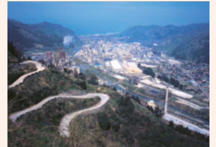
青海工場全景
