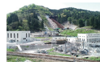
新姫川第六発電所(2022年送電開始)
