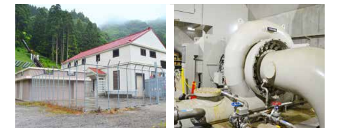
小滝川発電所
