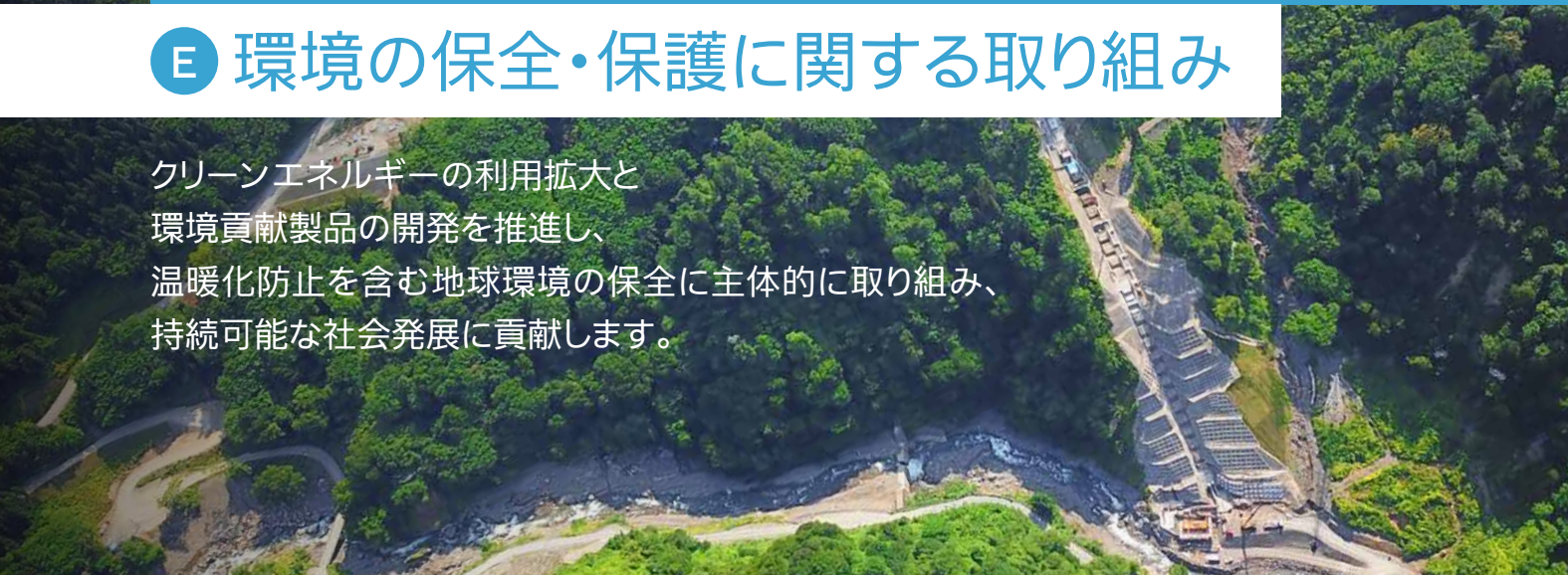
新規水力発電所建設風景(新青海川発電所)
