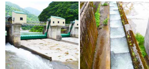
大網発電所の堰堤
