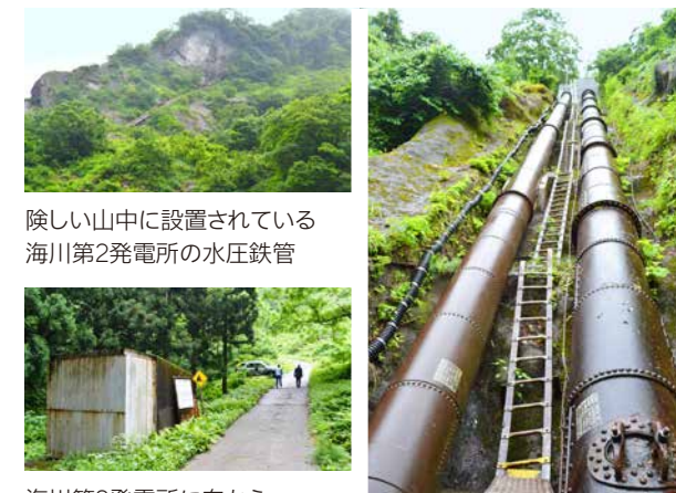
海川第2発電所の水圧鉄管路
