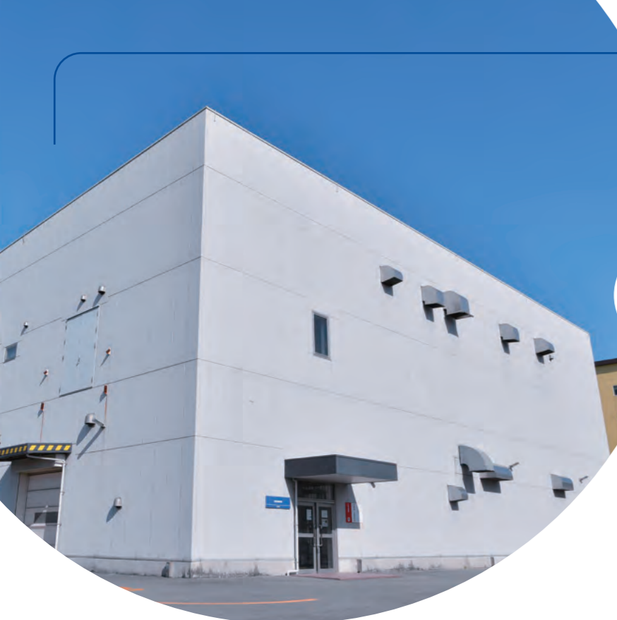
超微粉実験棟
