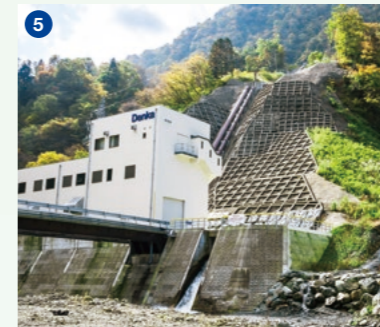
5 新青海川発電所(2021年送電開始)
