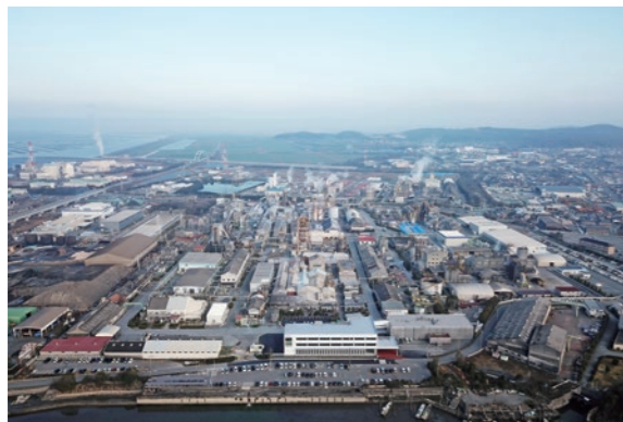
大牟田工場の全景 手前中央に見える白い建物が「Omuta Innovation Hub」
