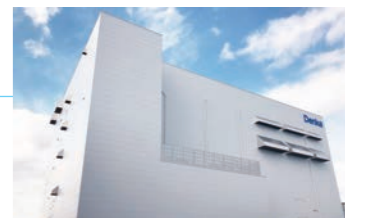
新潟工場42号棟
