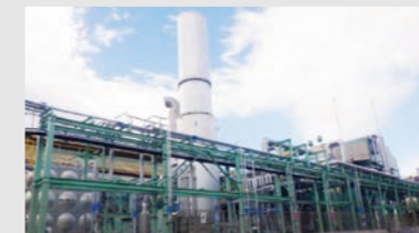
温室効果ガス削減のため、青海工場に高効率ガスタービン発電機を竣工（10月）
