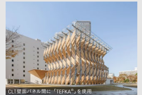
CLT壁面パネル間に「TEFKA®」を使用
