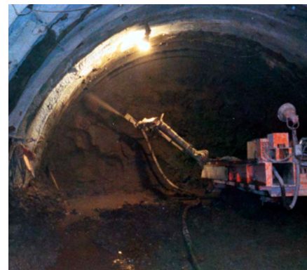
デンカナトミック®によるトンネル吹付け工事
