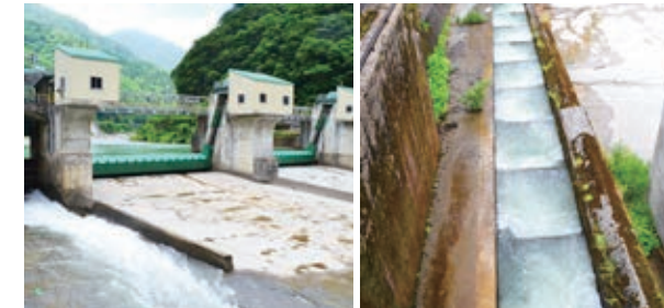
大网发电站的堤堰
