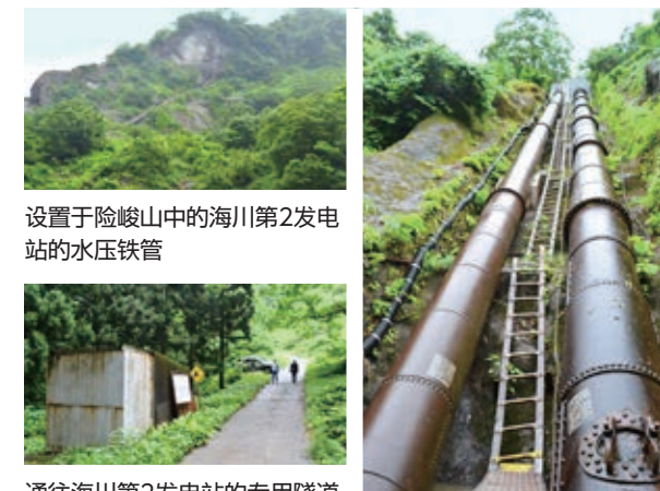
海川第2发电站的水压铁管
