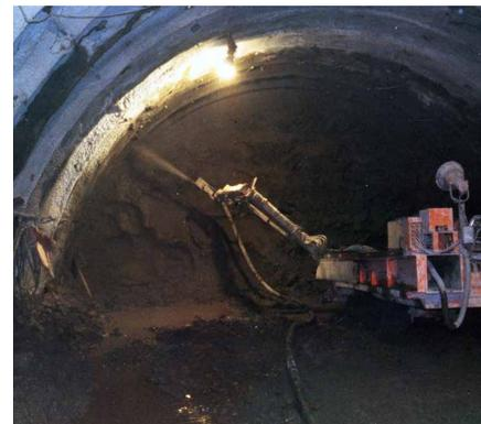
采用DENKA NATMIC进行隧道混凝土喷射施工
